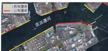
民有護岸と公有護岸の混在と災害の広域化の危険性
