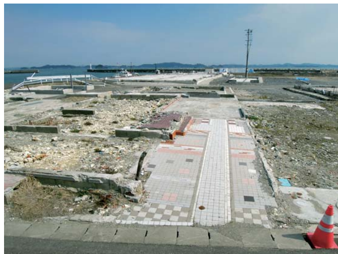
七ヶ浜の漁港沿岸の復興が進まない状況
