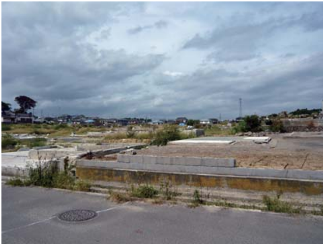
基礎だけ残して流された海岸線の家々の跡
